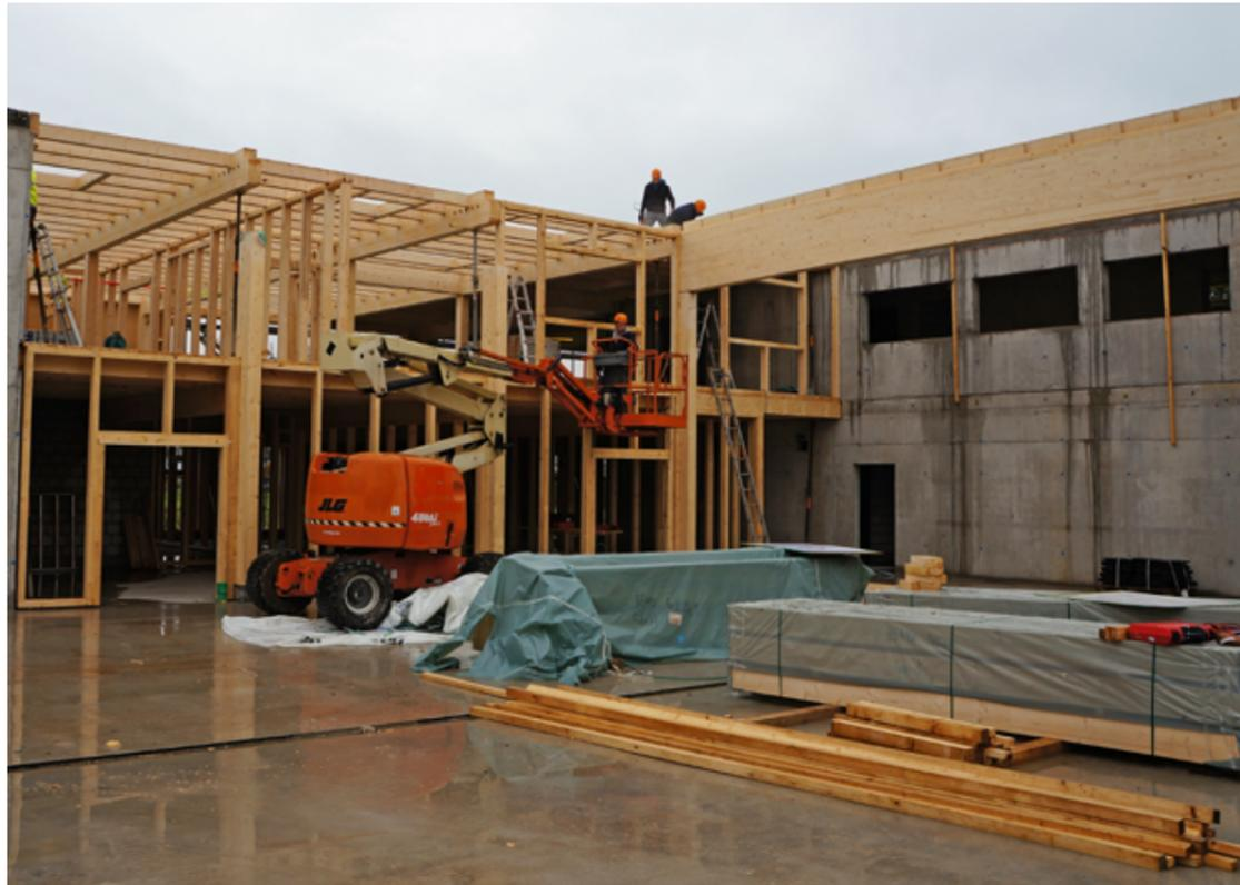
Holz allein, muss nicht sein: Das Feuerwehrmagazin in Lyss ist eine Holz-Beton-Konstruktion.
